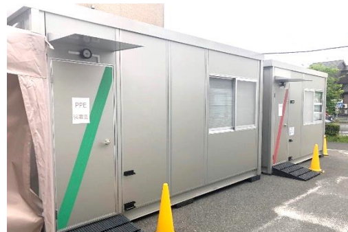
仮設プレハブ PPE 装着室とプレハブ診察室 2
